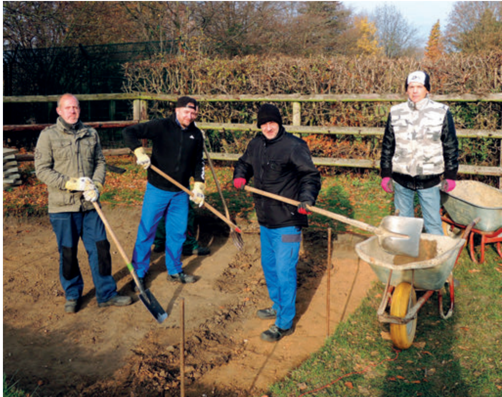
▲ Das Gartenbauteam bereitet das Fundament für die Pergola vor. Foto: bb
